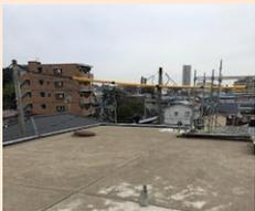
傷んだ箇所に細かい補修をしながら防水シートを敷き詰めます。
