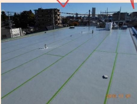
最後にウレタン塗装で最終仕上げ。二度塗りで防水対策はバッチリです！
